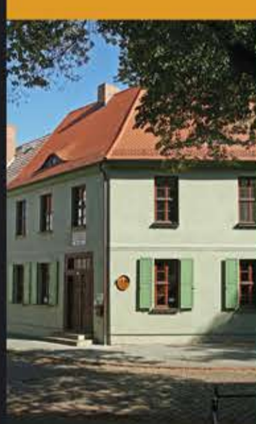
Das Hahnemann-Haus in der Wallstraße
